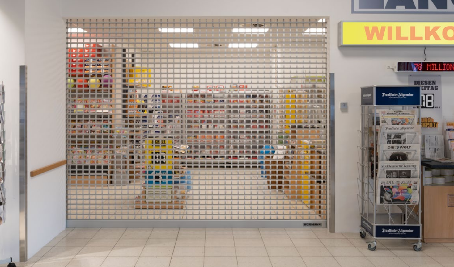
OVER. Portblad SR65-R med 60 x 44 mm rektangulære hull
