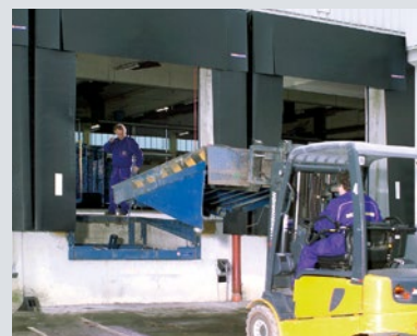
Demontere den gamle lastebryggen, ev. tilpasse graven (f.eks. med monteringsplater eller konsoller)
