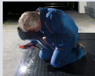
Sveis fast på kantvinklene – ferdig!
